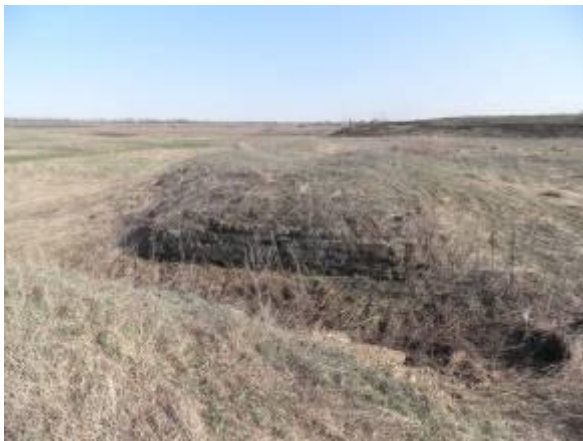
Остатки плотины на солевозной дороге
