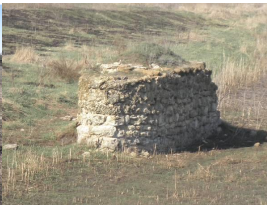
Опора моста через речку Двойная на солевозной дороге на сл. Б.Мартыновка
