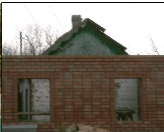
Рис. 10 Возведение новых стен вокруг старого флигеля
