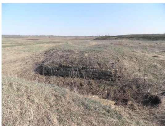
Остатки плотины на солевозной дороге
